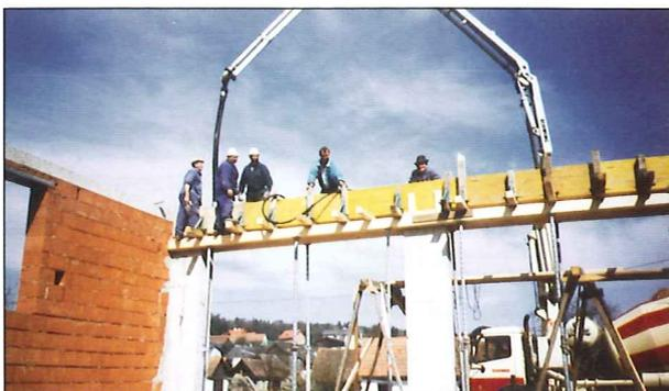
April 1997: Es wurden die Säulen und Träger bei der Fahrzeughalle betoniert.
