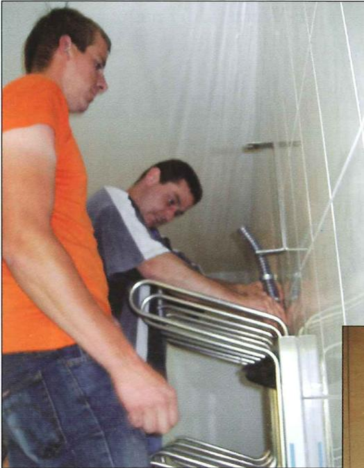
Trummer Armin und Resch Markus montieren die Atemschutztrochungsanlage.
